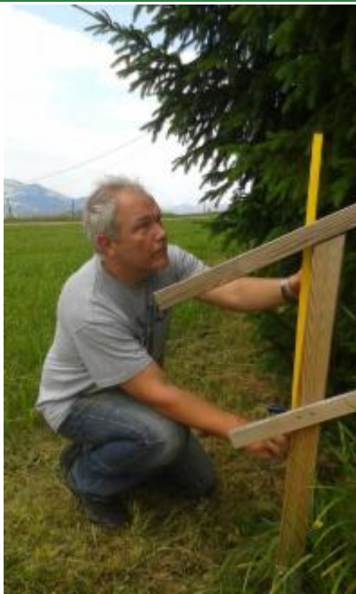
Didi stabilisiert das Treppengeländer mit zusätzlichen Streben
