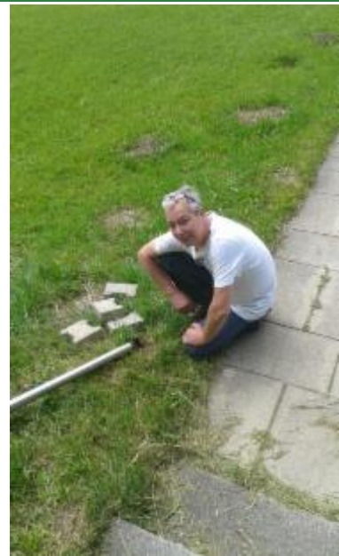
Ulli repariert die Treppenbeleuchtung
